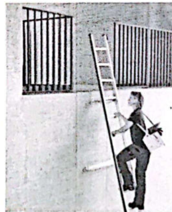
7 Come salire in condizioni di sicurezza: sguardo rivolto verso la scala, buone calzature, tenersi saldamente con due mani, trasporto del materiale nell'apposita cassetta
